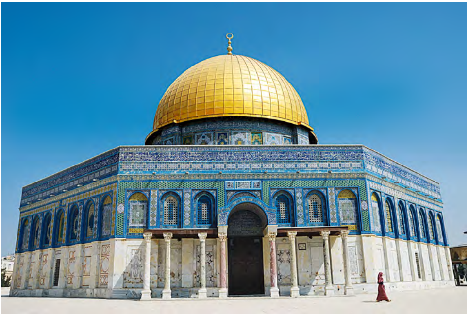
Figura 27 Domo da Rocha, exterior.
